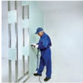
اجرای پانل ها در یک طرف دیوار
