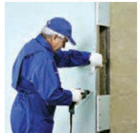
اجرای پانل ها در طرف دیگر دیوار
