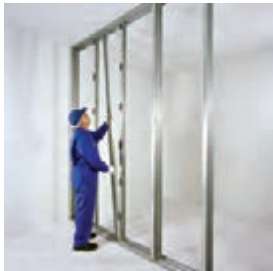
اجرای ردیف دوم استاداها
