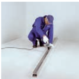
اجرای سازه سقفی دوتایی (در برخی ساختارها)
