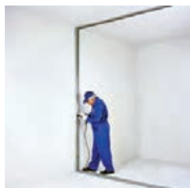
نصب استاد بر روی ساختار جانبی
