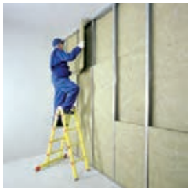
اجرای عایق پشم معدنی
