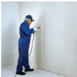
اجرای لایهٔ دوم پانل‌ها
