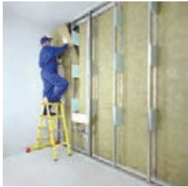
اجرای پانل ها در یک طرف دیوار
