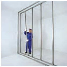
اجرای ردیف اول استاداها
