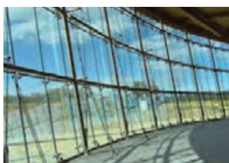
نمای شیشه‌ای با سیستم اسپایدر (سیستم عنکبوتی)
