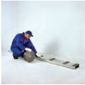
اجرای نوار عایق بر روی استاداها
